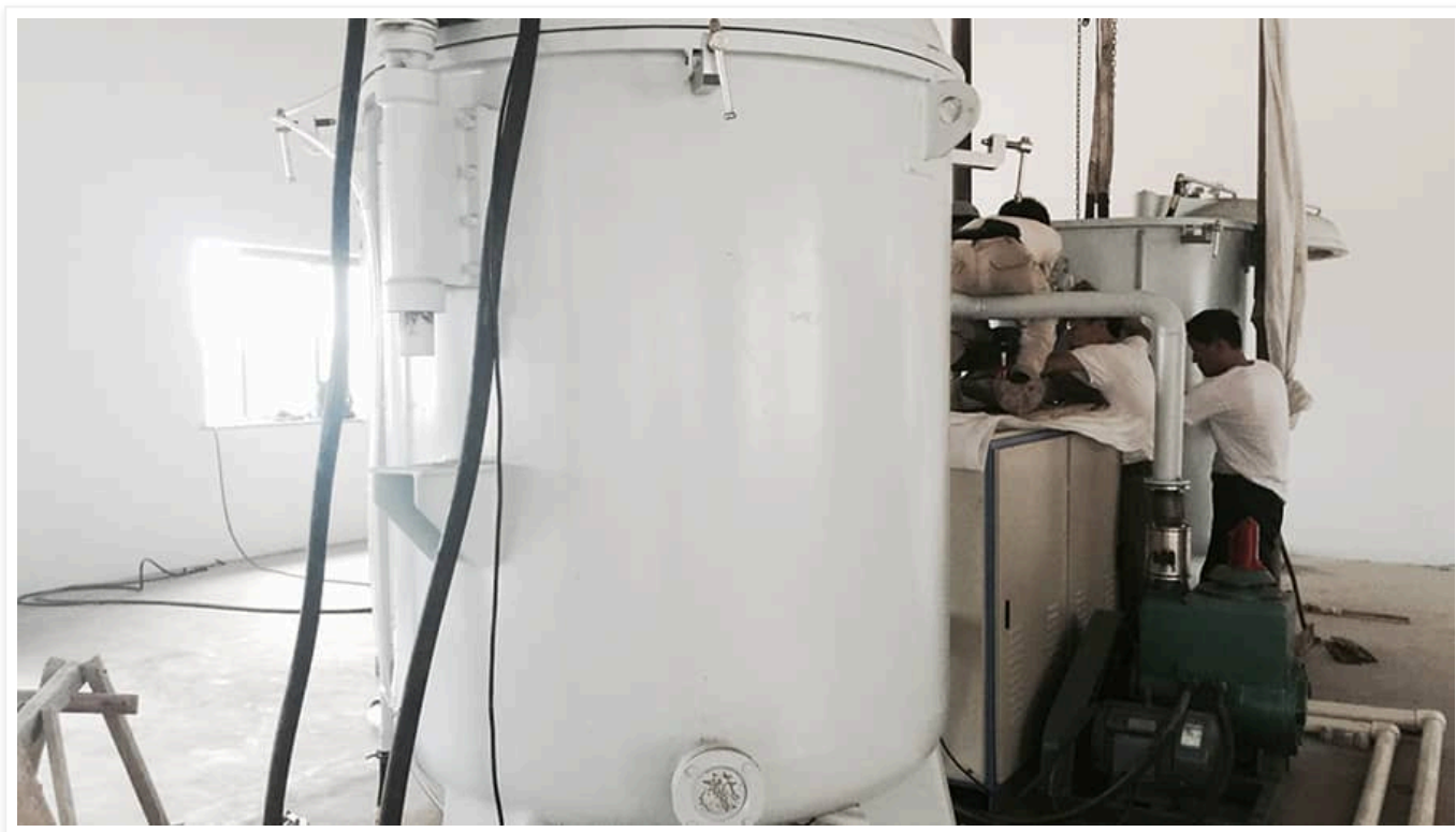
图：远航 工业炉 -立式超高温石墨化现场安装
